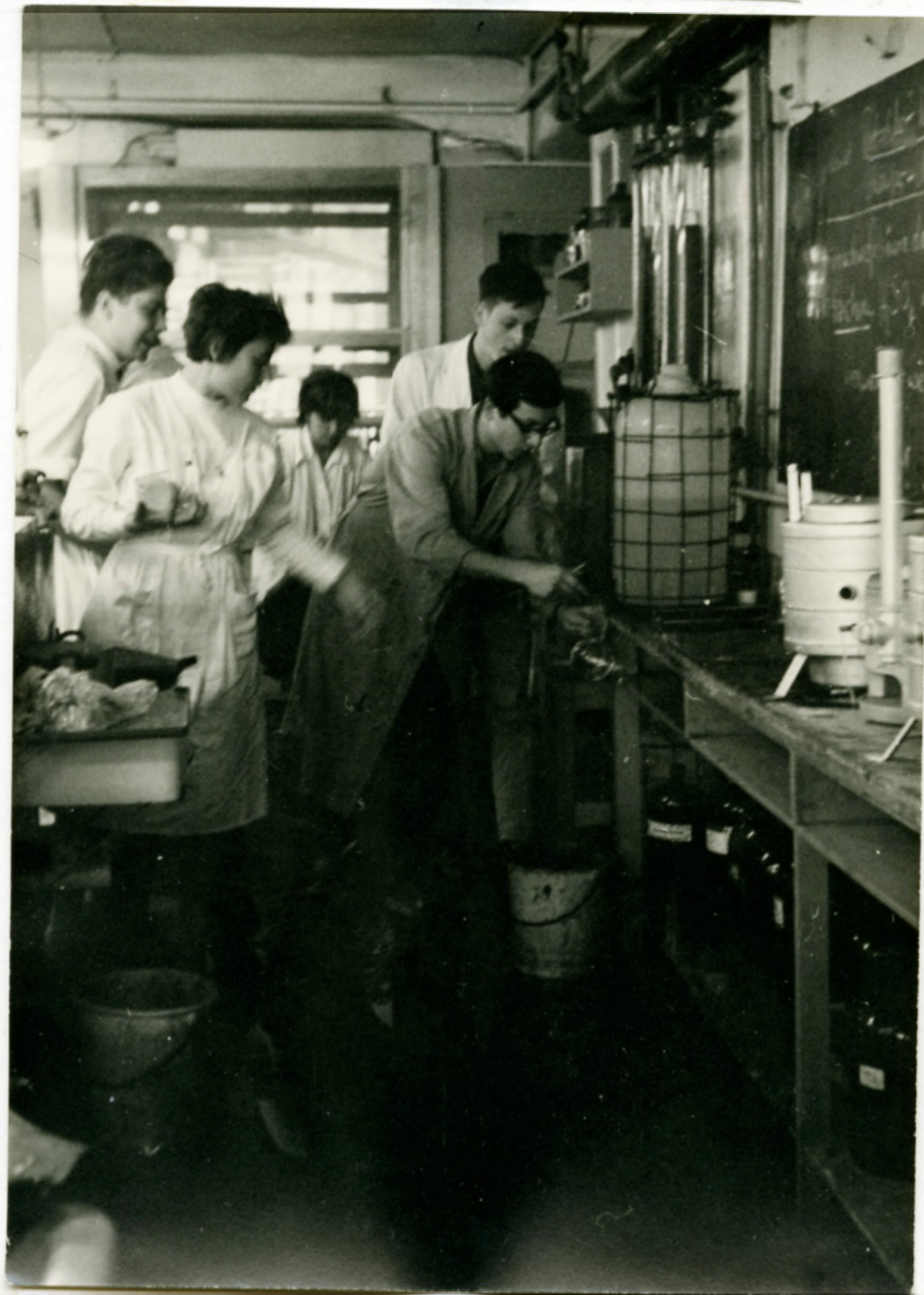
Zapfstelle für destilliertes Wasser
